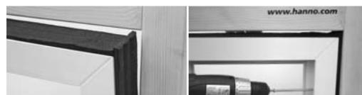
框架连同Hannoband-3E胶带插入墙上洞孔，用通常的承重空间准备螺丝钉预先钻孔并安装。
