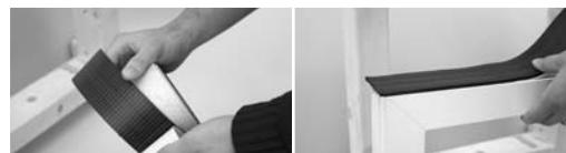
去除覆盖纸大约20cm。将胶带粘附在窗架上，留下额外的长度（较低接缝宽度的尺寸）。
