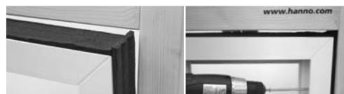
Blendrahmen mit Hannoband®-3E in die Maueröffnung stellen, Löcher vorbohren und mit handelsüblichen, lastabtragenden Distanz-Befestigungs-Schrauben montieren.
