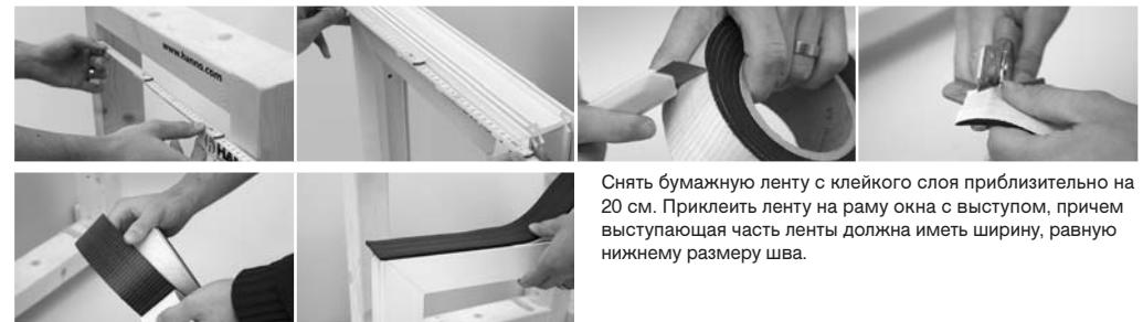
Снять бумажную ленту с клейкого слоя приблизительно на 20 см. Приклейте ленту на раму окна с выступом, причем выступающая часть ленты должна иметь ширину, равную нижнему размеру шва.
