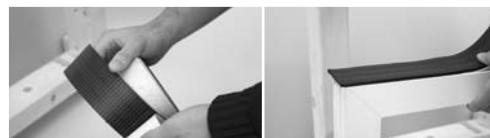
Abdeckpapier ca. 20 cm entfernen. Band mit Überstand (unteres Fugenbreitenmaß) auf den Blendrahmen kleben.
