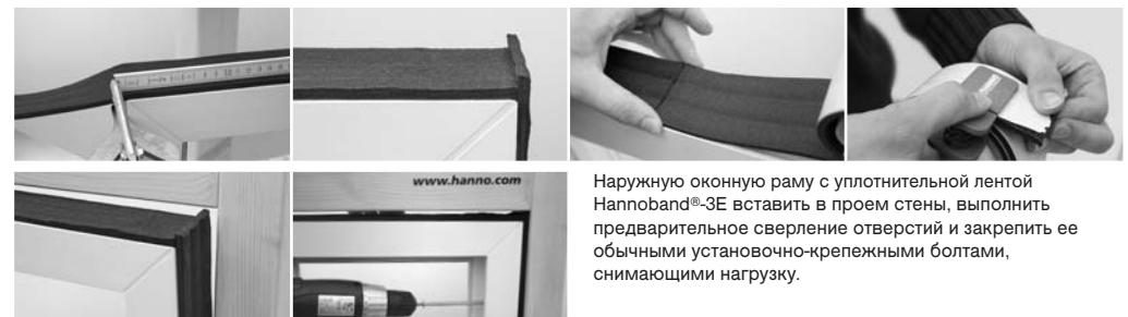
Наружную оконную раму с уплотнительной лентой Hannoband®-3E вставить в проем стены, выполнить предварительное сверление отверстий и закрепить ее обычными установочно-крепежными болтами, снимающими нагрузку.
