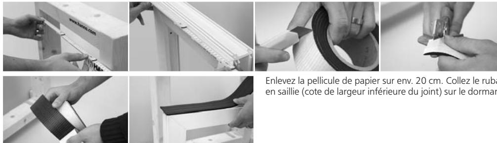
Sectionnez le ruban dans l'angle supérieur en laissant une saillie (cote de joint supérieure) et faites-le arriver bord à bord dans l'angle, en affleurement avec le bord extérieur du dormant. En fin de rouleau, posez le nouveau ruban bord à bord et sectionnez les deux derniers et premiers centimètres. Comblez les joints d'aboutement / ébréchures à l'aide d'un mastic d'étanchéité approprié (p. ex. colle pour bande pare-vapeur 3E MS Hanno®).
