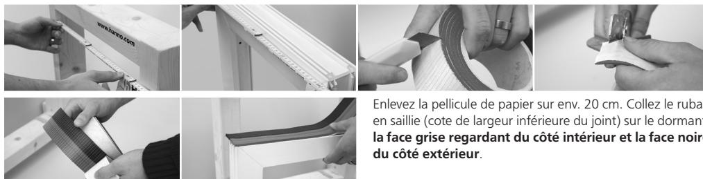
Enlevez la pellicule de papier sur env. 20 cm. Collez le ruban en saillie (cote de largeur inférieure du joint) sur le dormant, **la face grise regardant du côté intérieur et la face noire du côté extérieur.**
