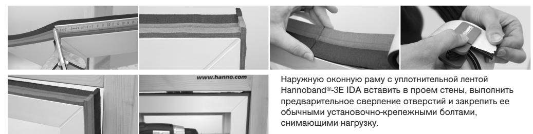
Наружную оконную раму с уплотнительной лентой Hannoband®-3E IDA вставить в проем стены, выполнить предварительное сверление отверстий и закрепить ее обычными установочно-крепежными болтами, снимающими нагрузку.
