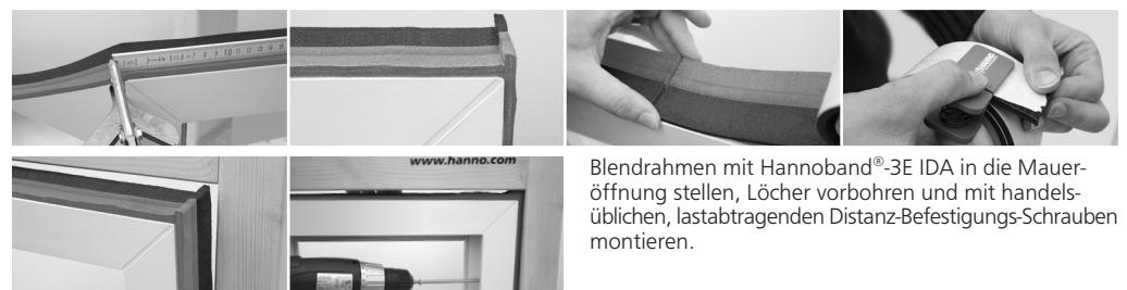
Blendrahmen mit Hannoband®-3E IDA in die Maueröffnung stellen, Löcher vorbohren und mit handelsüblichen, lastabtragenden Distanz-Befestigungs-Schrauben montieren.
