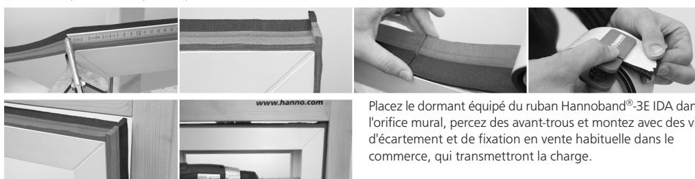
Placez le dormant équipé du ruban Hannoband®-3E IDA dans l'orifice mural, percez des avant-trous et montez avec des vis d'écartement et de fixation en vente habituelle dans le commerce, qui transmettront la charge.
