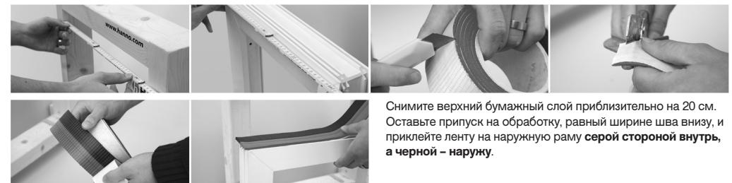
Снимите верхний бумажный слой приблизительно на 20 см. Оставьте припуск на обработку, равный ширине шва внизу, и приклейте ленту на наружную раму **серой стороной внутрь, а черной – наружу.**
